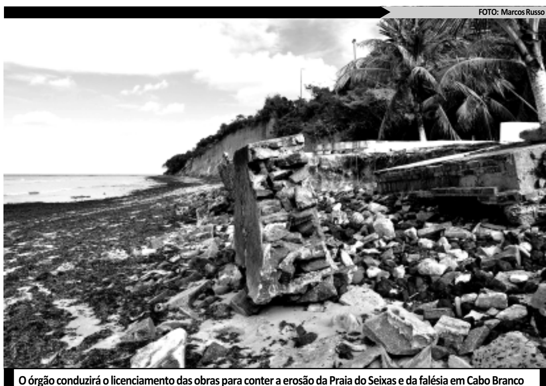
O órgão conduzirá o licenciamento das obras para conter a erosão da Praia do Seixas e da falésia em Cabo Branco
