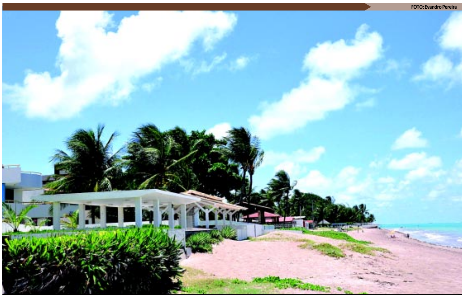
Na orla de Cabedelo, residências que violaram o limite de faixa da União terão 30 dias para fazer o recuo ou correm o risco de demolição parcial
